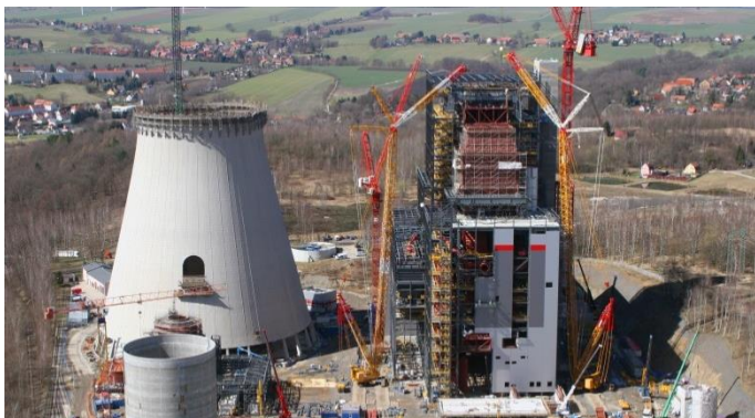
Projekt Turów – budowa bloku o mocy 490 MW
