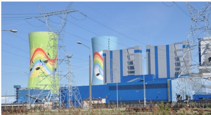
Projekt Opole II – budowa bloków o mocy 1.800 MW
