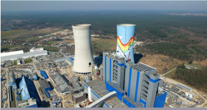
Projekt Opole II – budowa bloków o mocy 1 800 MW
