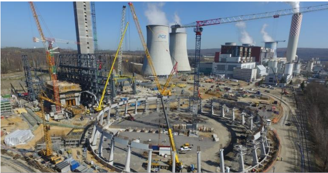
Projekt Turów – budowa bloku o mocy 490 MW
