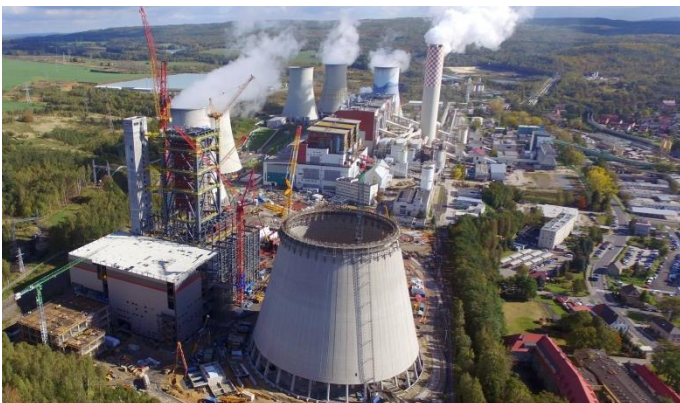
Projekt Turów – budowa bloku o mocy 490 MW
