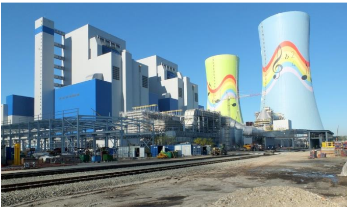
Projekt Opole II – budowa bloków o mocy 1 800 MW
